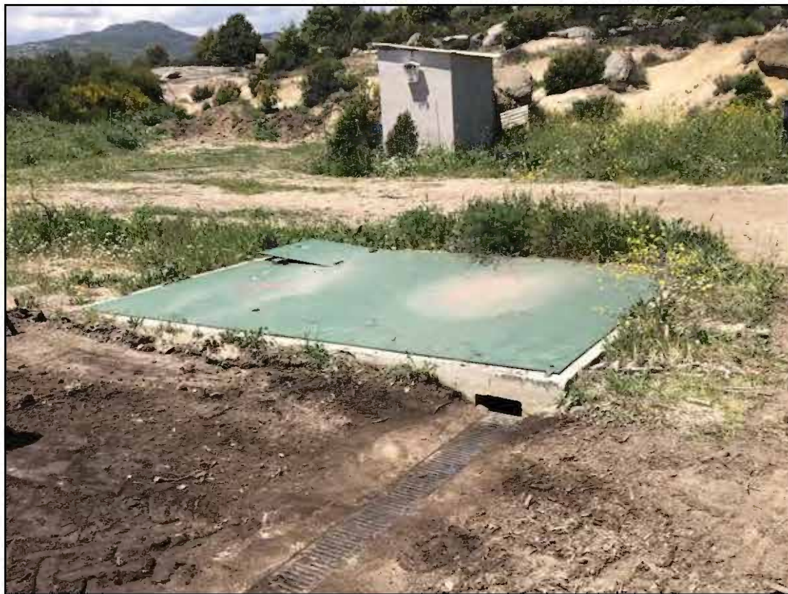
Imagen 7. Canaletas de hormigón y balsa de lixiviados de la plataforma antigua. Al fondo caseta del pozo
