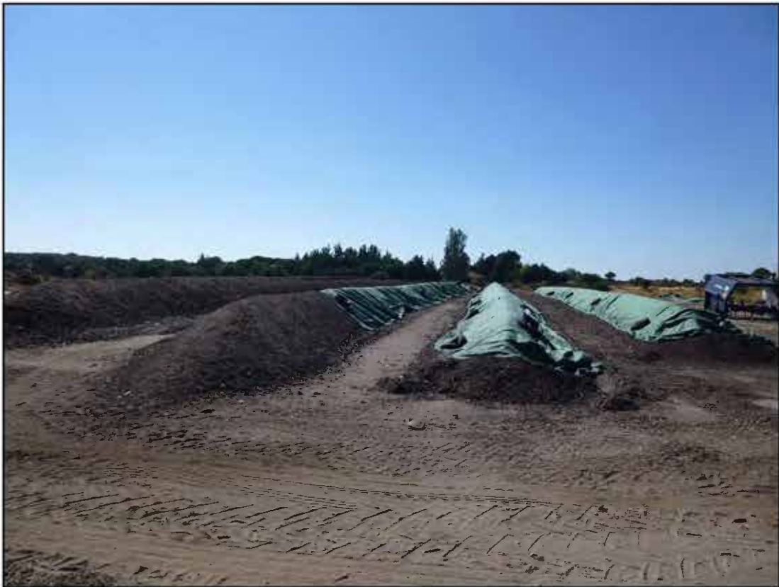
Imagen 1. Izquierda: Zona de Maduración dinámica. Derecha: zona de maduración estática (geotextiles)
